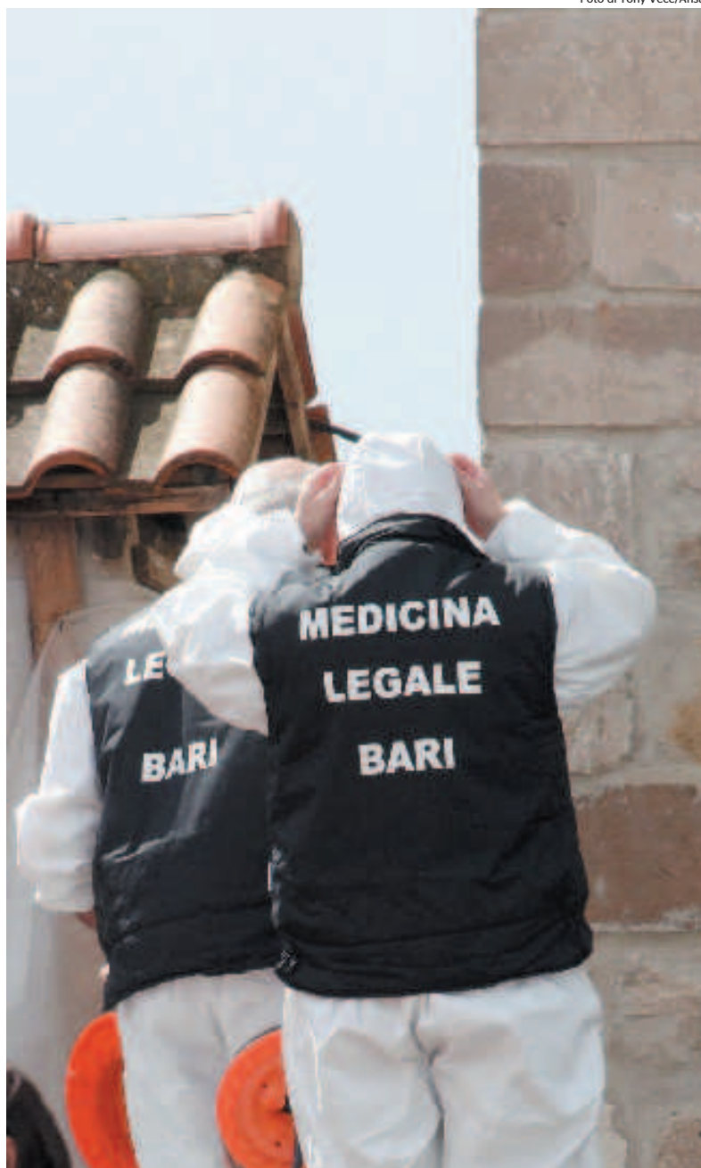
L'ultimo sopralluogo sul tetto della chiesa della Santissima Trinità
