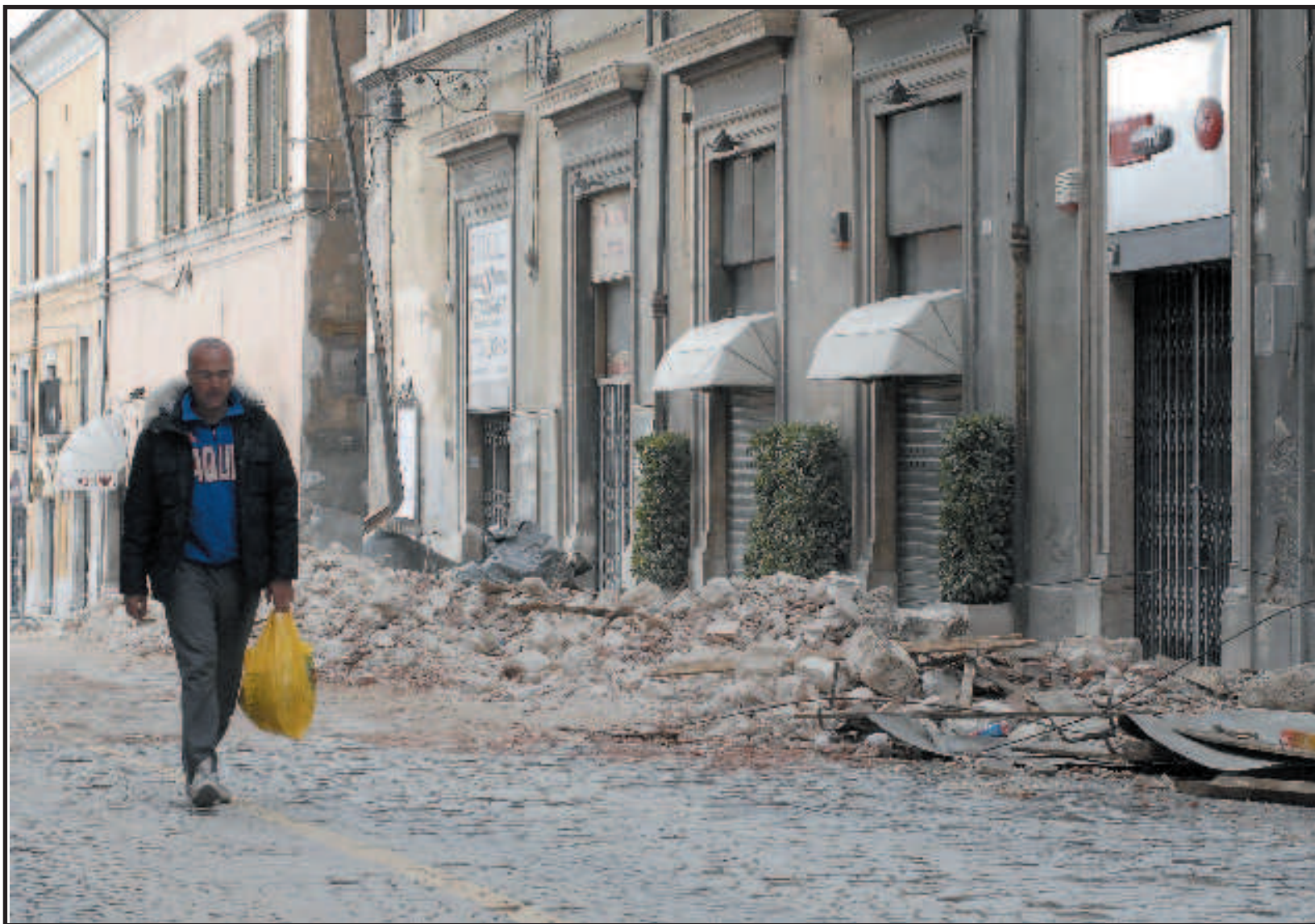
PERSISTE La distruzione provocata dal terremoto
