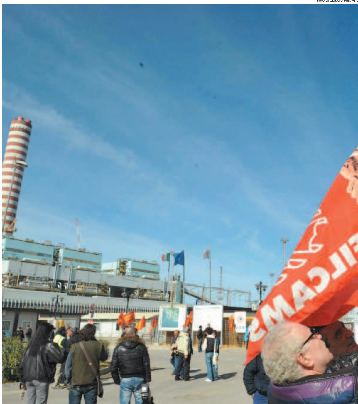
La centrale Enel di Torre Valdaliga Nord a Civitavecchia (Rm)
