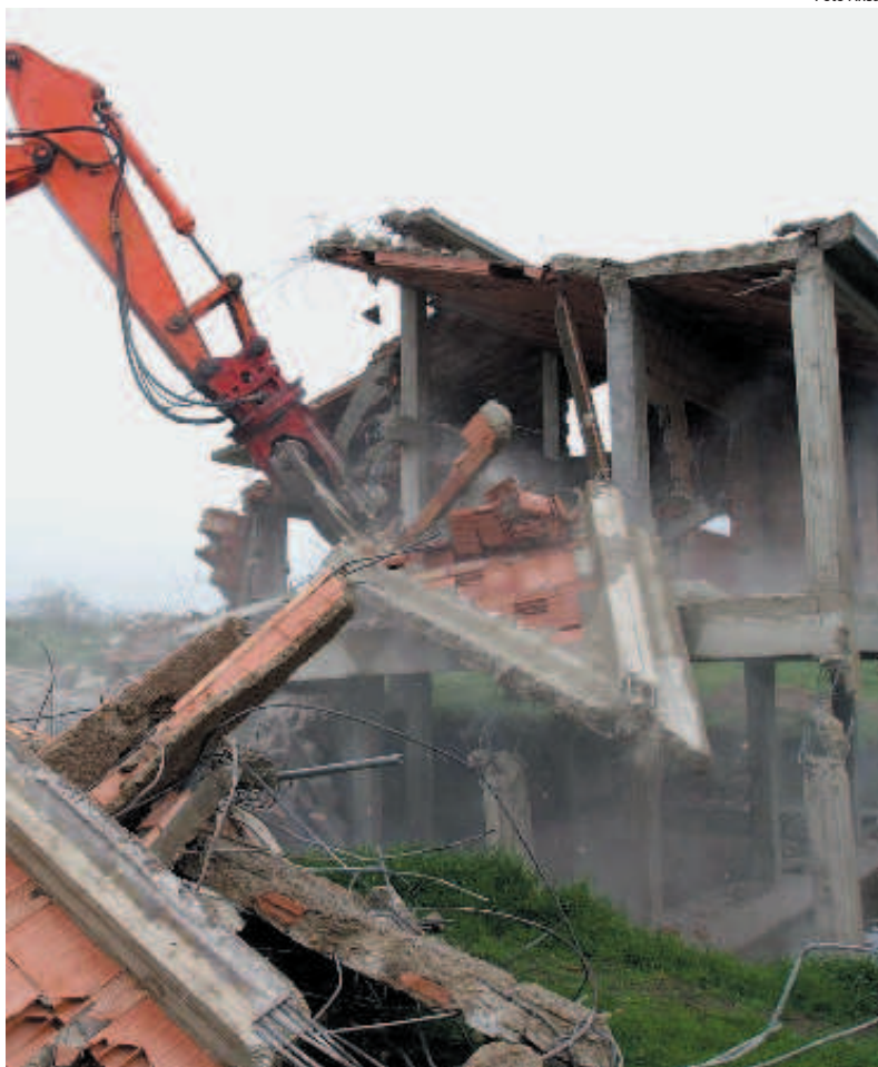
Demolizione di un fabbricato abusivo in una zona periferica di Roma
