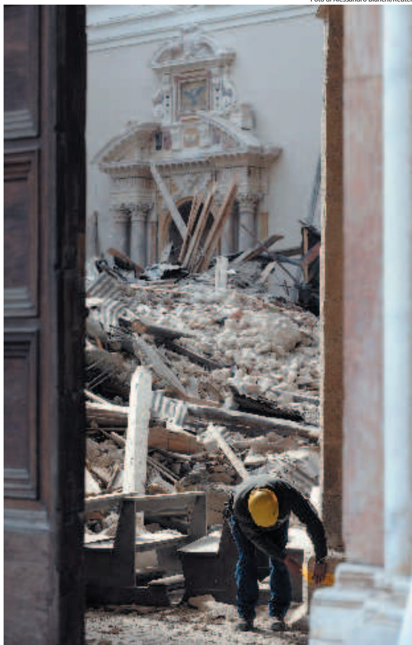
Lavori alla Chiesa di S. Maria di Collemaggio
