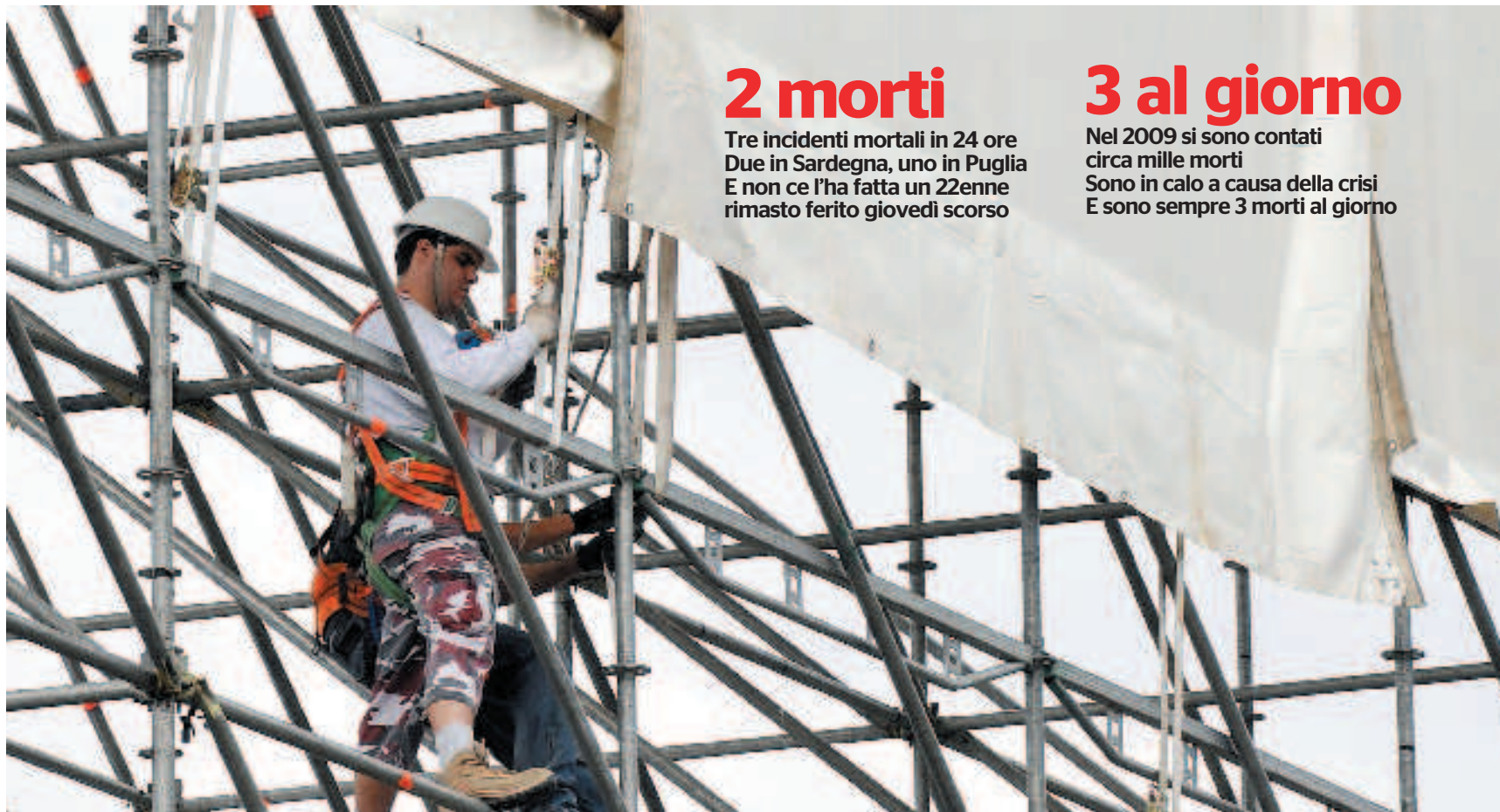
Operai al lavoro sulle impalcature
