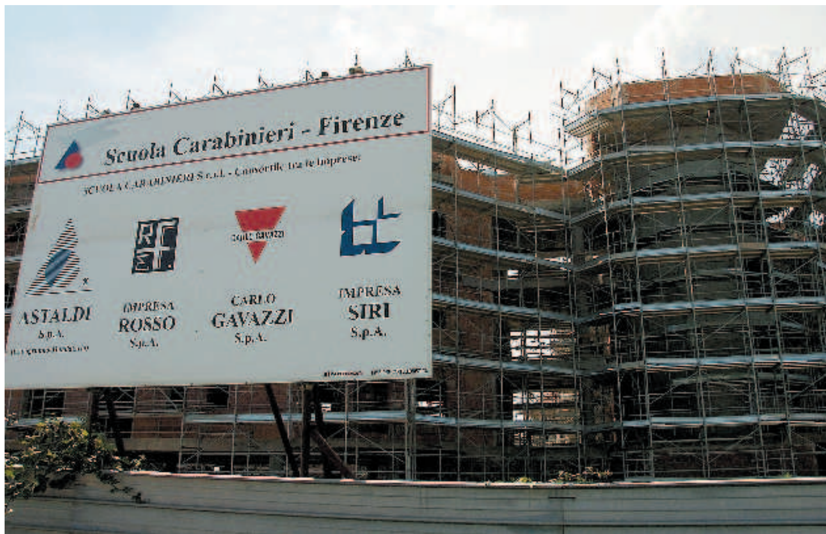
Il cantiere fiorentino della Scuola dei Marescialli
