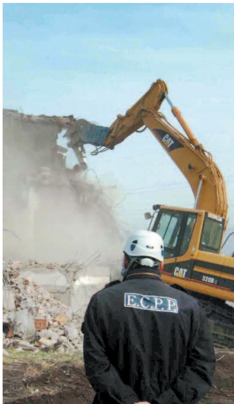
Un'immagine d'archivio che mostra l'abbattimento di una costruzione abusiva
