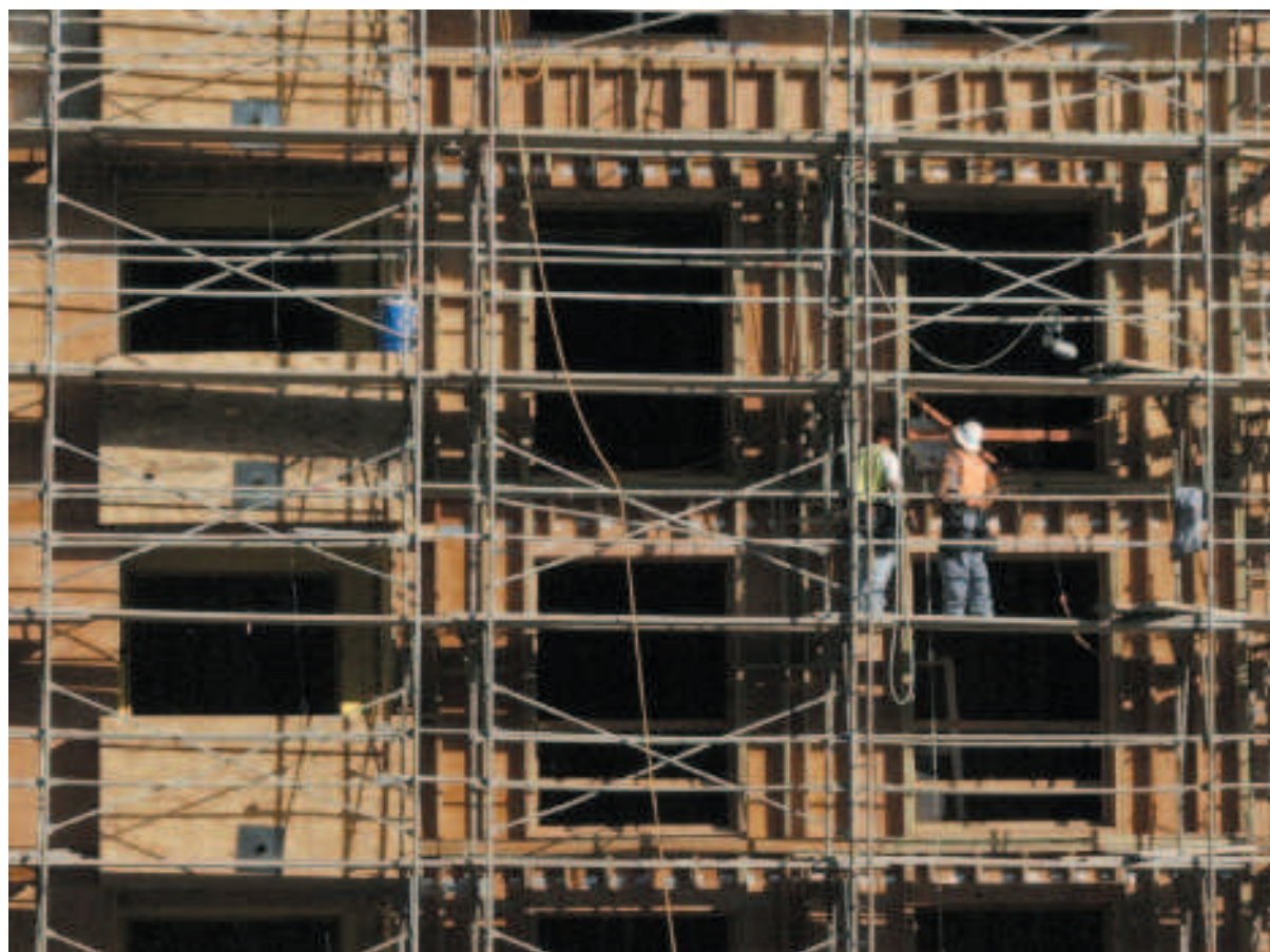
Un cantiere di un edificio
