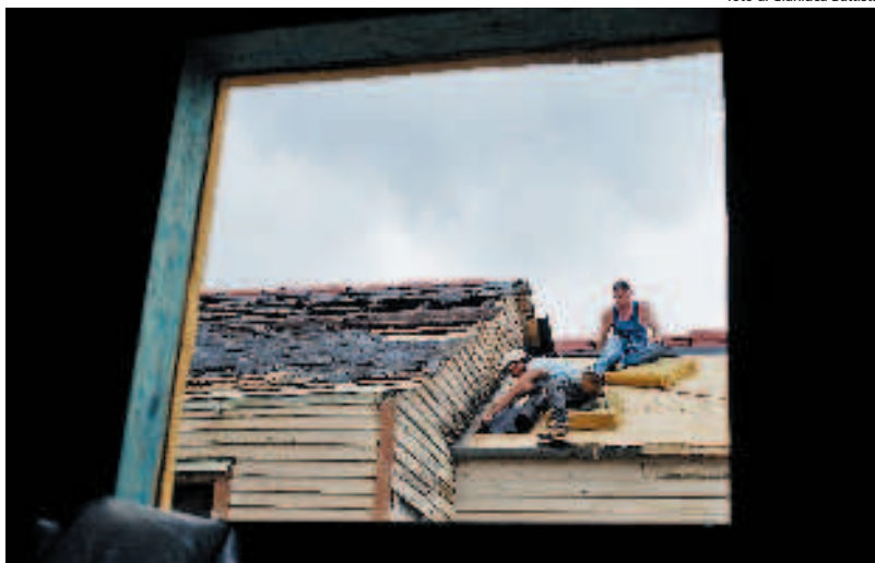
Lavori in corso sul tetto di una casa di Holy Cross
