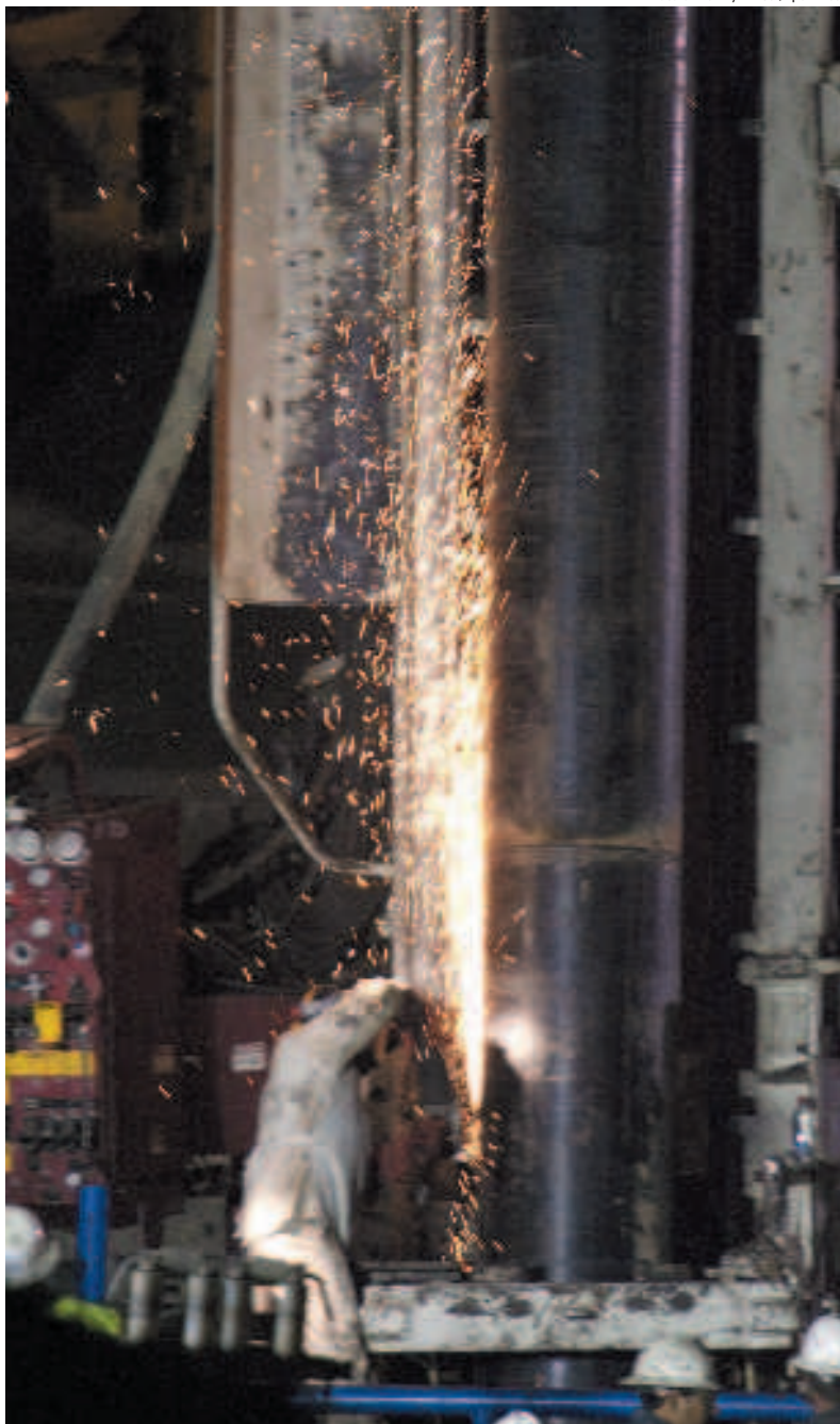
Ultimi sforzi per «encamisamiento» dei primi 96 metri del tunnel ascensionale
