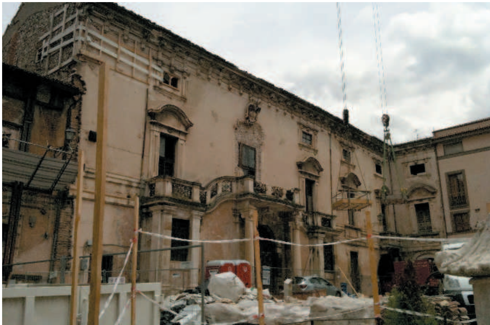
Un palazzo in ricostruzione a l'Aquila
