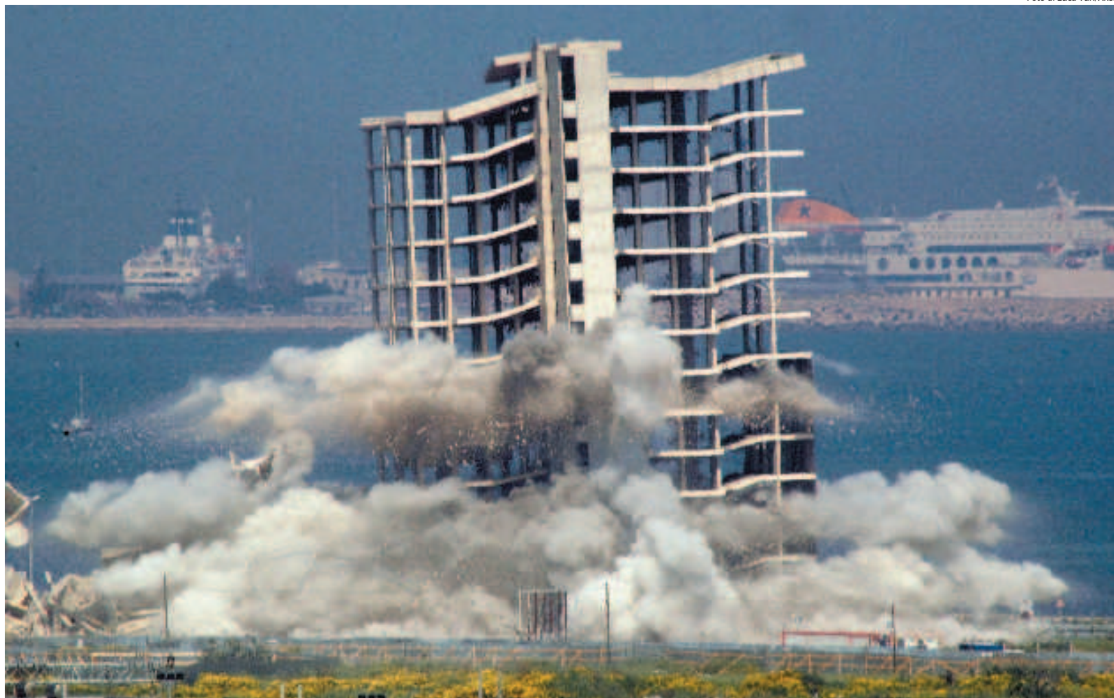
2 aprile 2006 Le cariche di tritolo fanno saltare la prima parte dell'ecomostro di Punta Perotti
