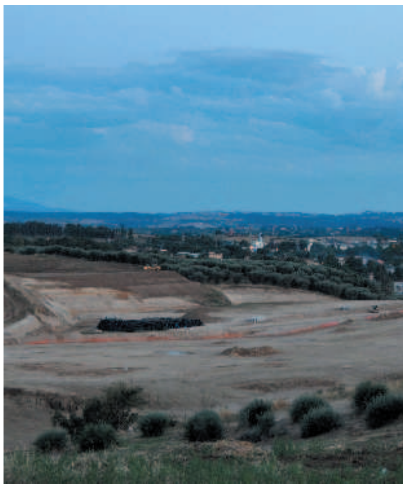
Dopo l'inizio dei lavori ecco come appare oggi l'area dopo l'arrivo delle ruspe
