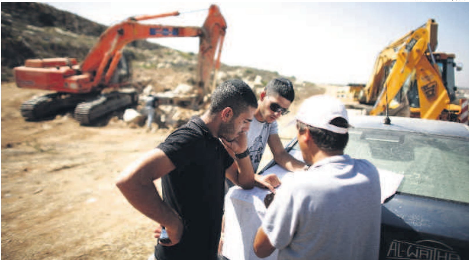
Le colonie Ruspe al lavoro per la costruzione di nuove case nell'insediamento israeliano di Ariel
