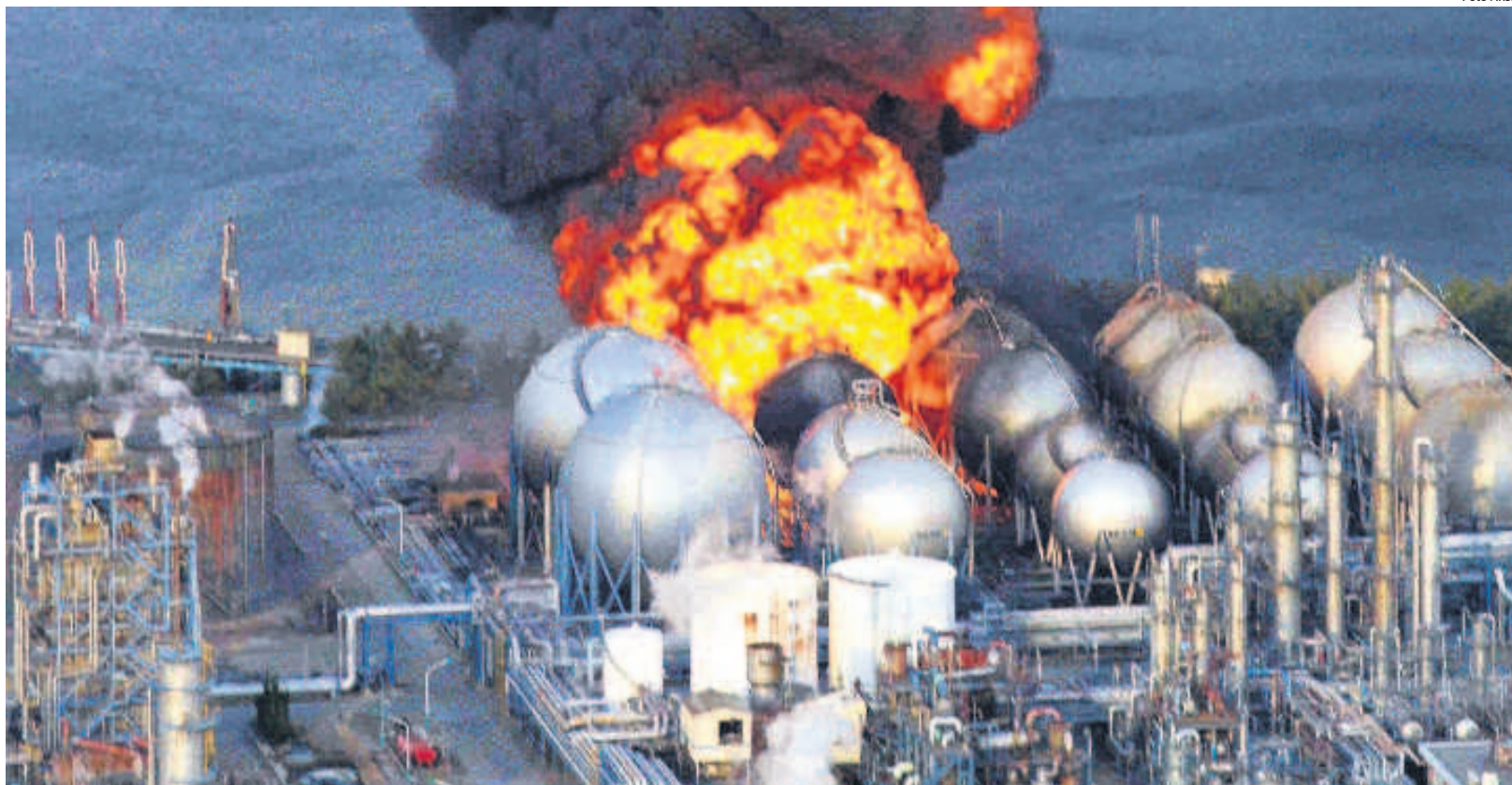
La raffineria di Chiba in fiamme dopo la scossa che ha colpito il nord della penisola di Hokkaido
