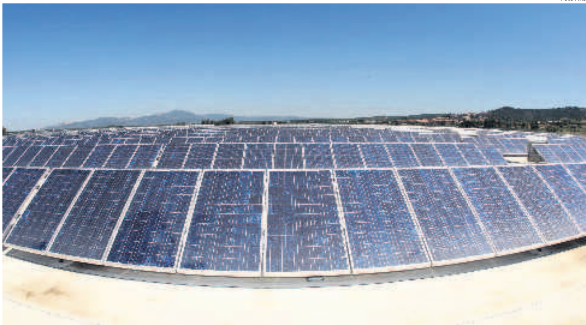
L'impianto fotovoltaico 'Il sole di Vignale' di 15.000 mq di pannelli fotovoltaici in Toscana
