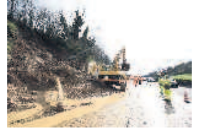
I lavori per liberare la sede della A1
