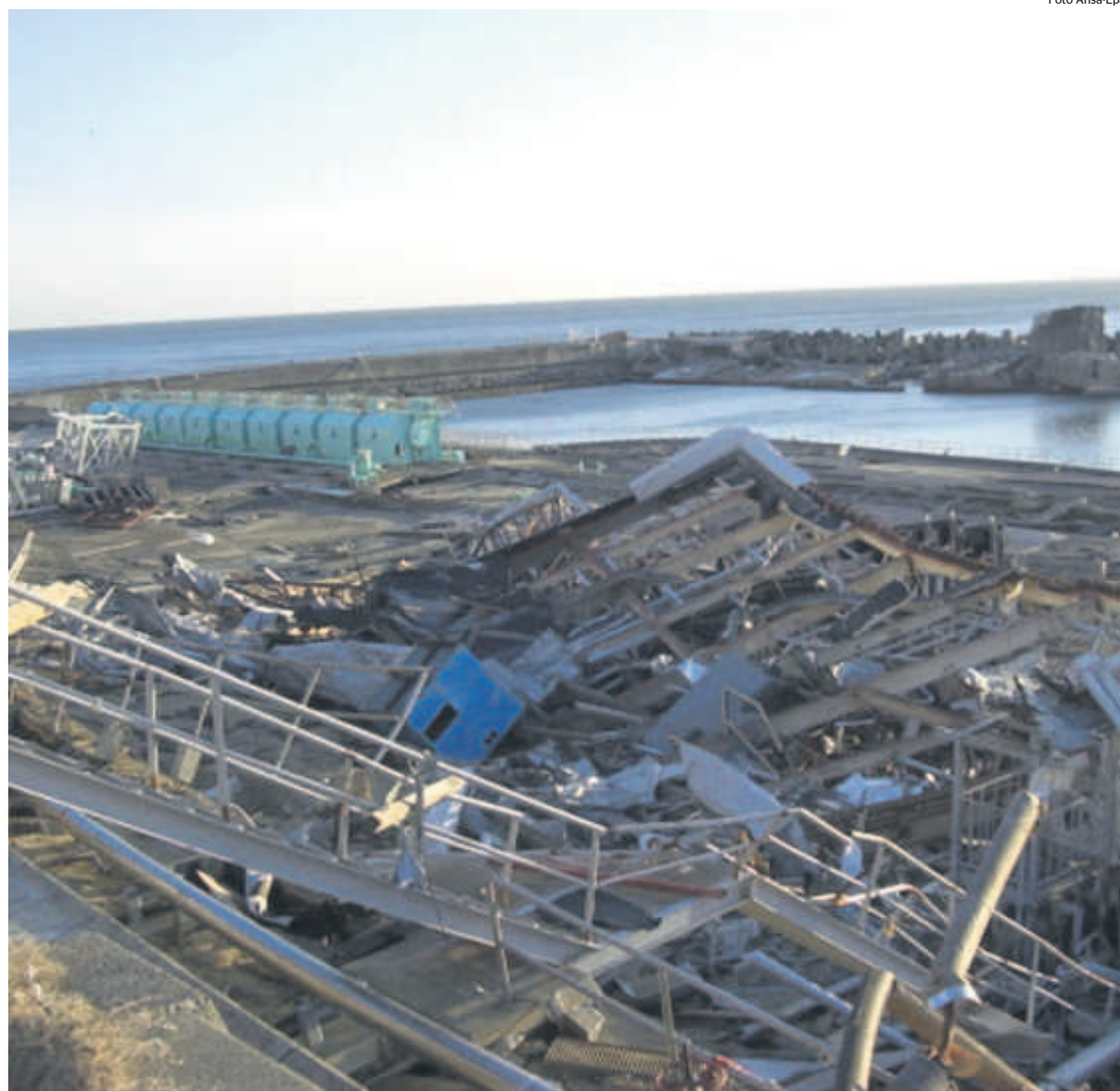
L'impianto Tepco mentre i tecnici tentano di trasferire acqua altamente radioattiva in un serbatoio di stoccaggio
