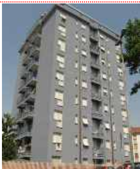
RISTRUTTURAZIONE EDIFICI SETTIMO MILANESE
