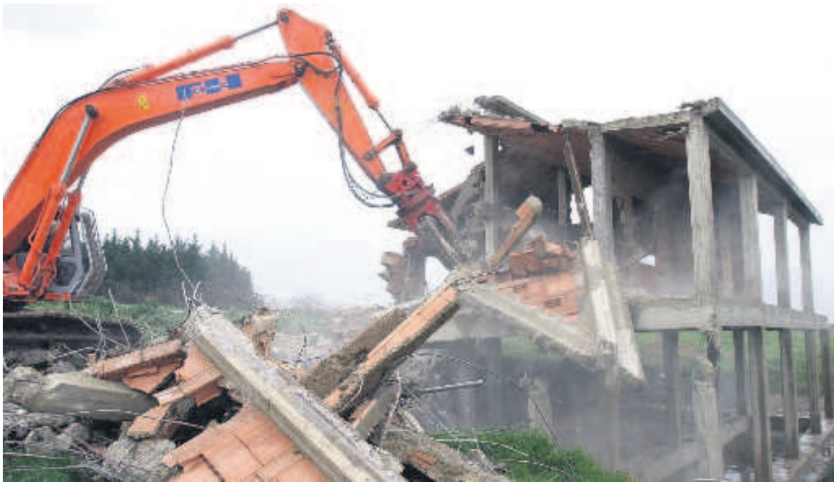
La demolizione di un fabbricato abusivo in una zona periferica di Roma
