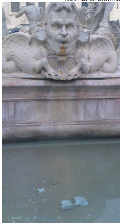
Il danneggiamento alla fontana del Moro
