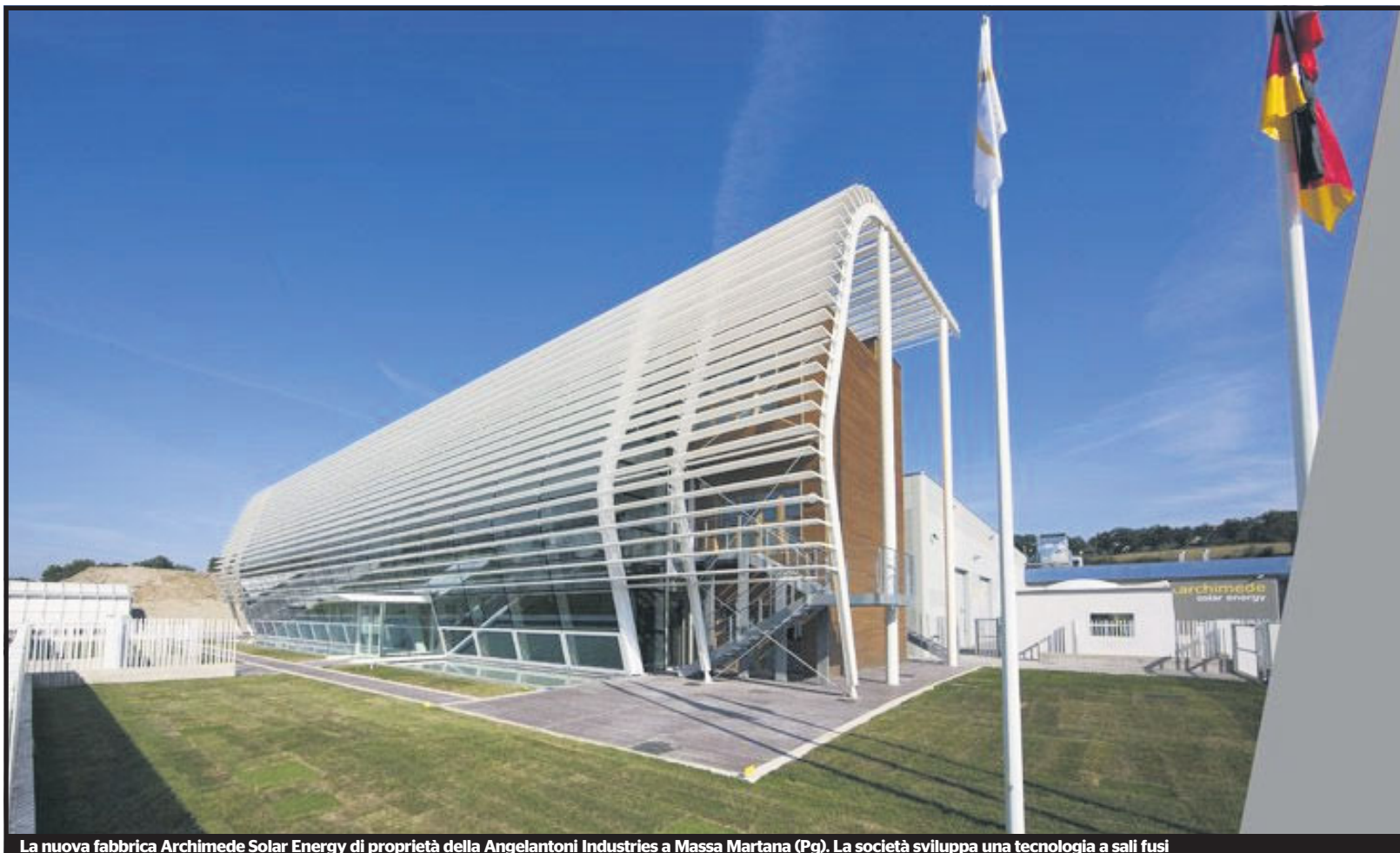
La nuova fabbrica Archimede Solar Energy di proprietà della Angelantoni Industries a Massa Martana (Pg). La società sviluppa una tecnologia a sali fusi
