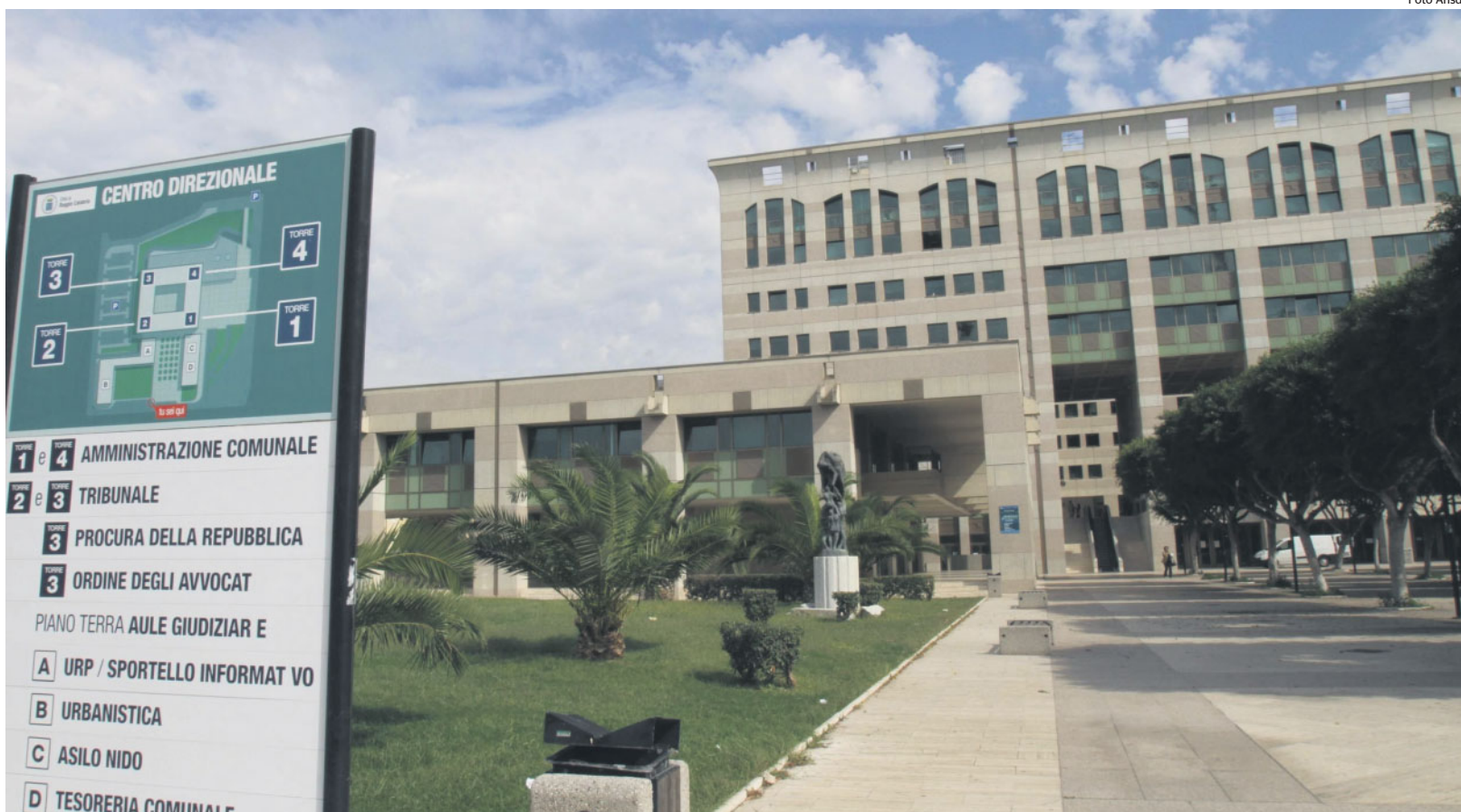
Il palazzo CeDir di Reggio Calabria, nel quale ci sono una parte degli uffici comunali
