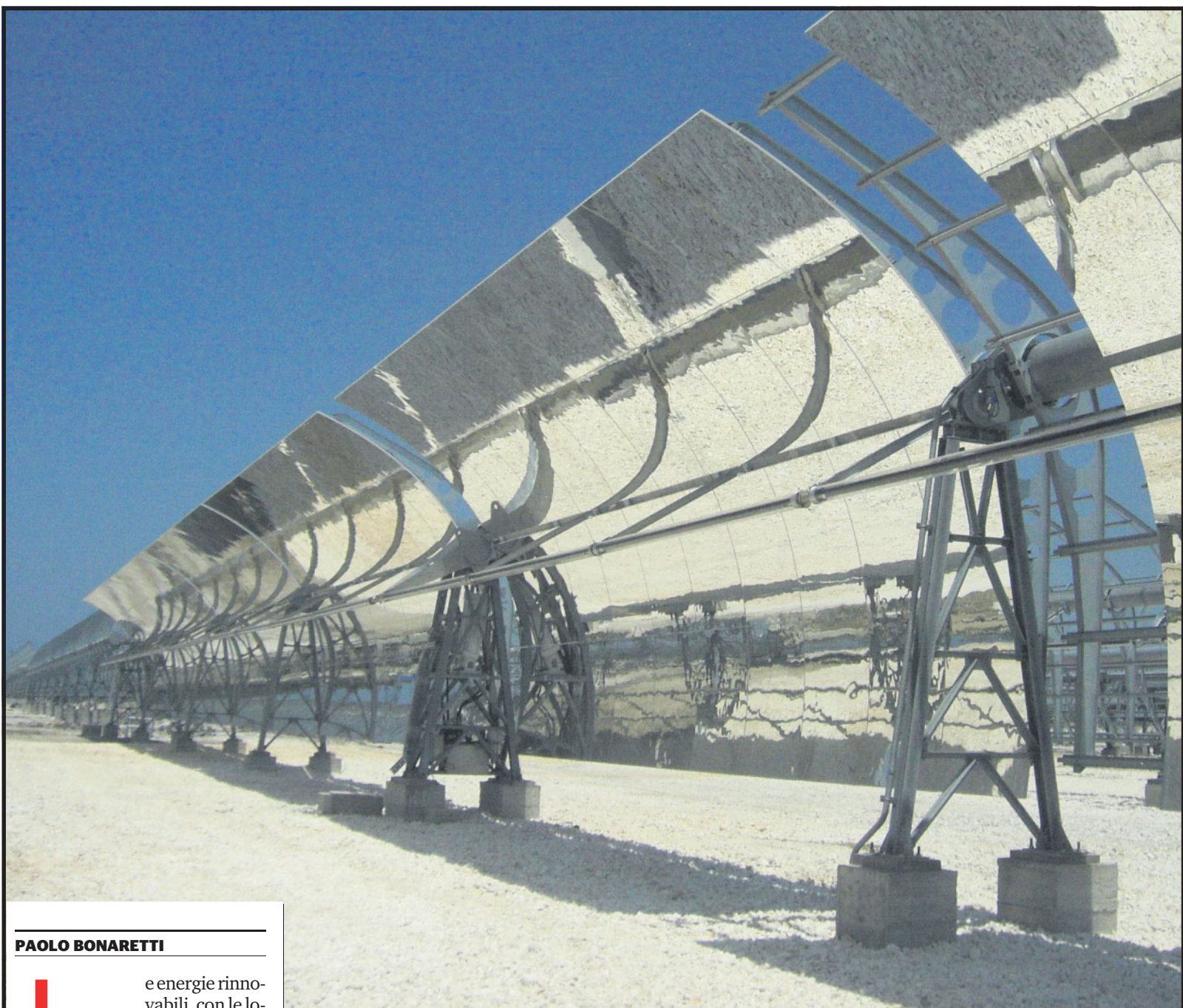
Catania, lo stabilimento 3 Sun (Enel Green Power, Sharp, STMicroelectronics) per pannelli fotovoltaici
