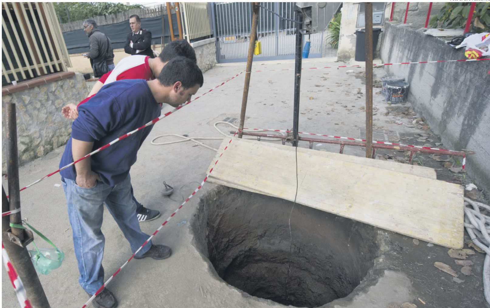
Il pozzo artesiano dove sono morti due operai di Ottaviano mentre stavano lavorando all'ampliamento di un pozzo a Somma Vesuviana
