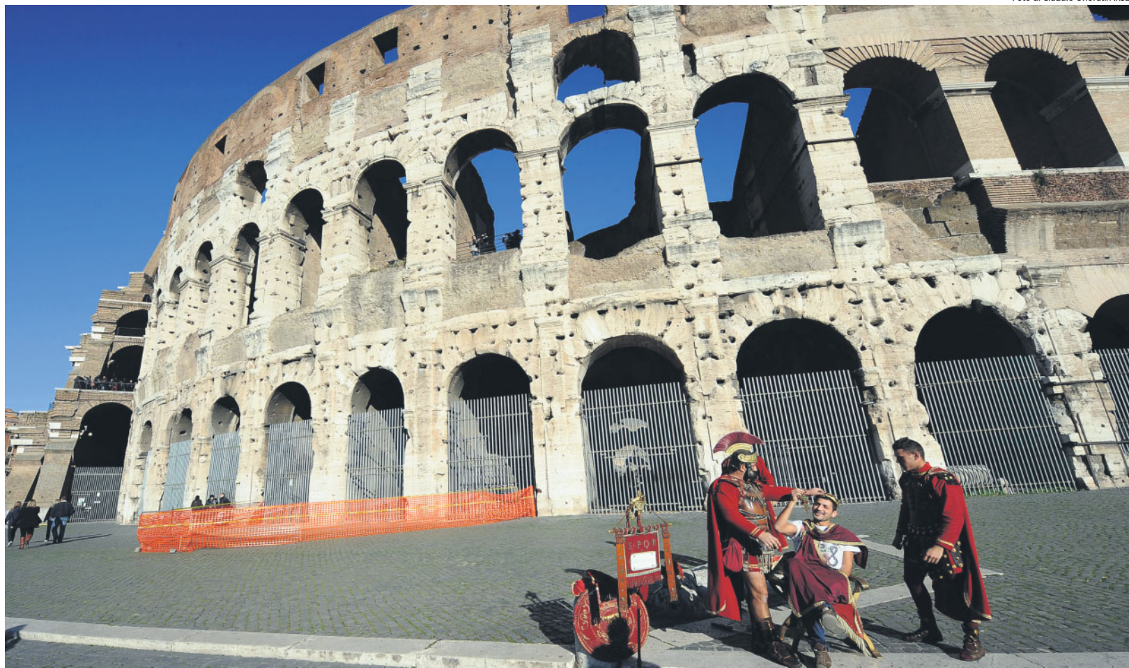
Negli ultimi giorni dal Colosseo si sono staccati altri frammenti
