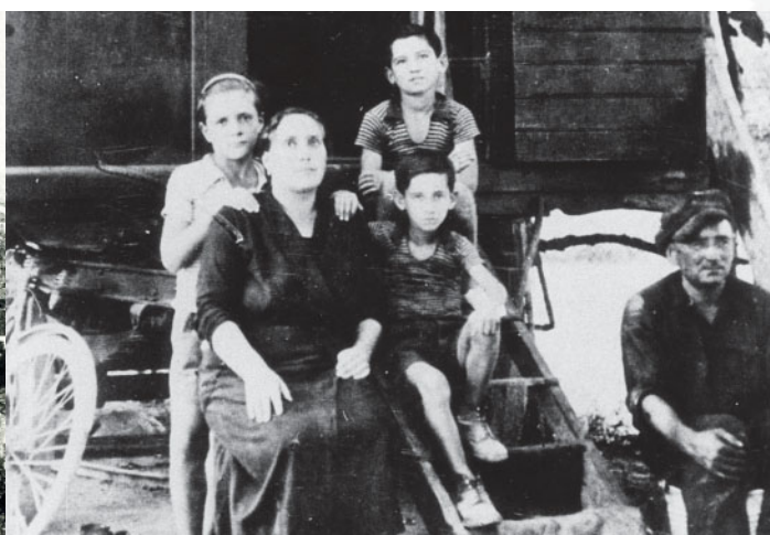
La famiglia di Vincenzo Martino, per molti anni Presidente della Coop Costruzioni di Bologna, cooperativa associata al CCC. Vivevano nel cantiere in un carro che si intravede alle spalle. Anni '30.
