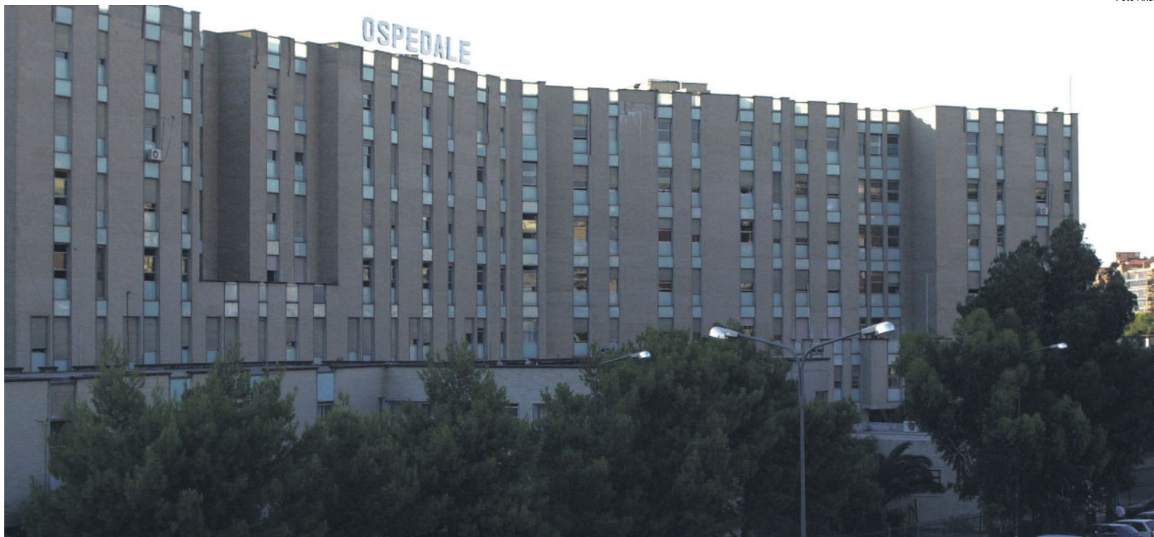
L'ospedale San Giovanni di Dio di Crotona dove venerdì è morta, dopo il parto cesareo, la diciannovenne Gessica Rita Spina
