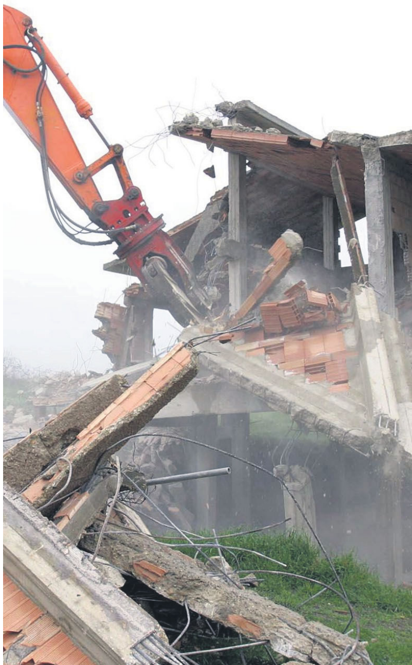
Demolizione di un fabbricato abusivo
