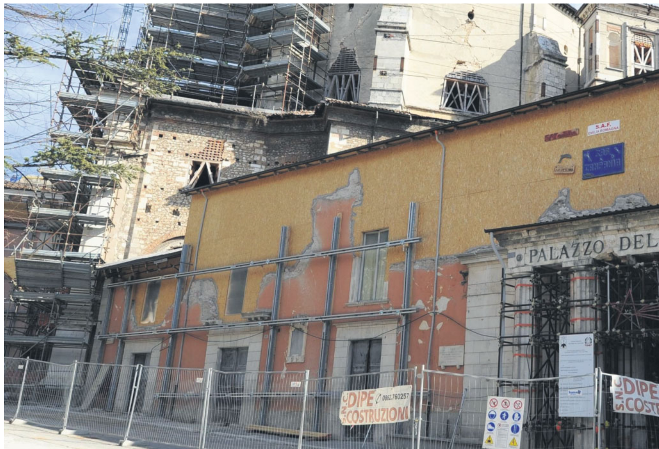
I lavori di restauro del palazzo della Prefettura dell'Aquila
