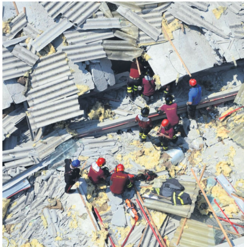
Vigili del Fuoco alla ricerca di superstiti sotto le macerie di un capannone FOTO ANSA
