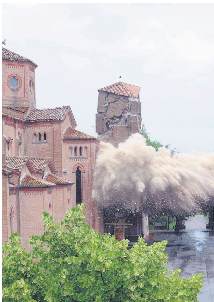
L'abbattimento del campanile di Poggio Renatico (Ferrara) FOTO INFOPHOTO
