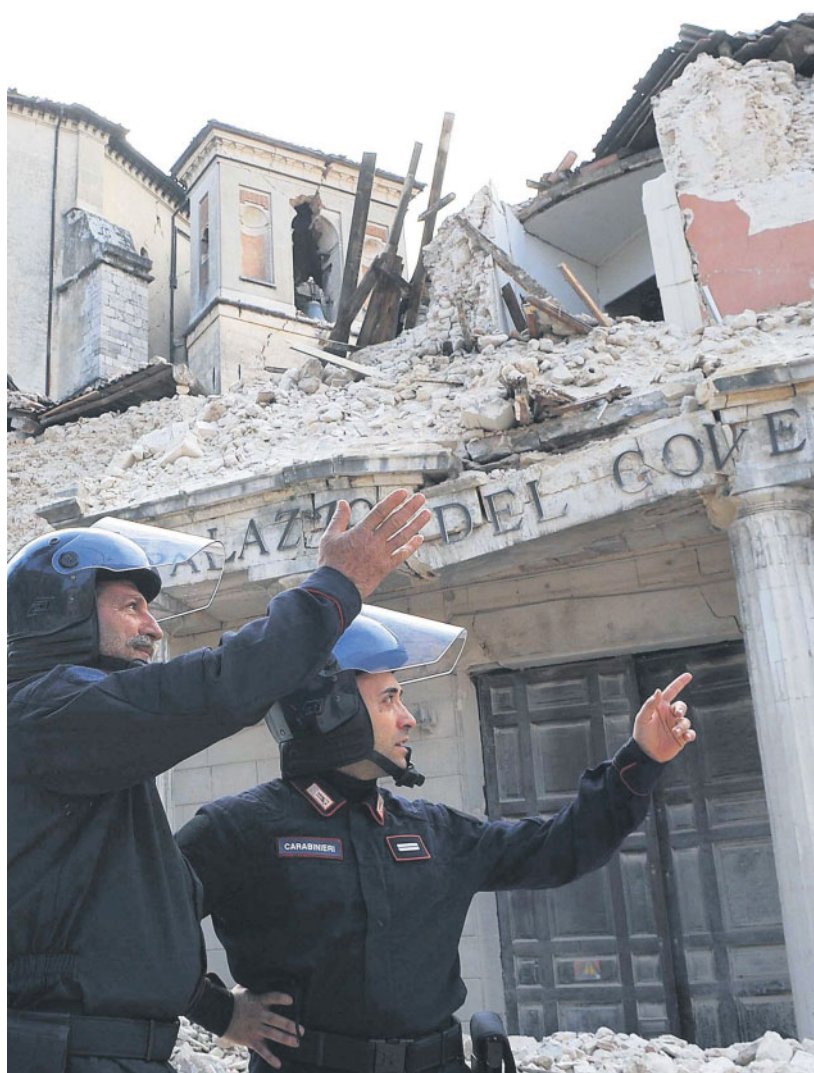
Il palazzo della prefettura dell'Aquila dopo il terremoto FOTO ANSA
