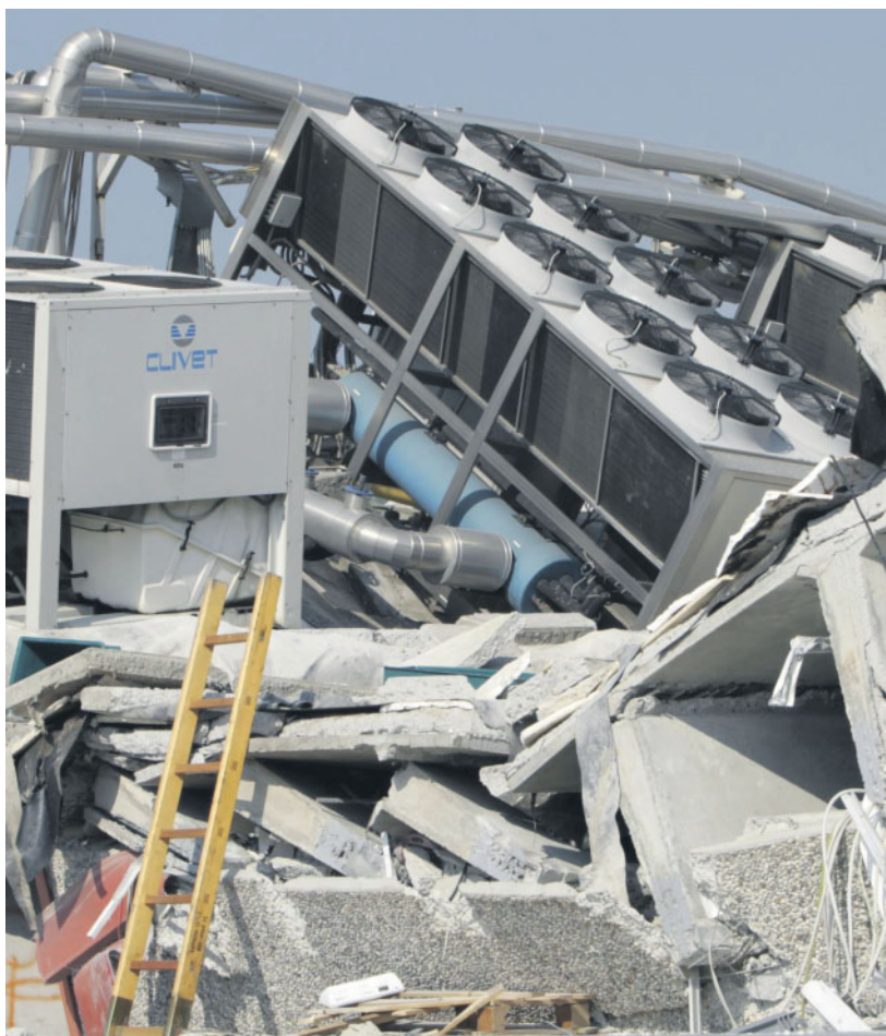
I resti di un capannone crollato dopo la scossa sismica del 30 maggio FOTO ANSA
