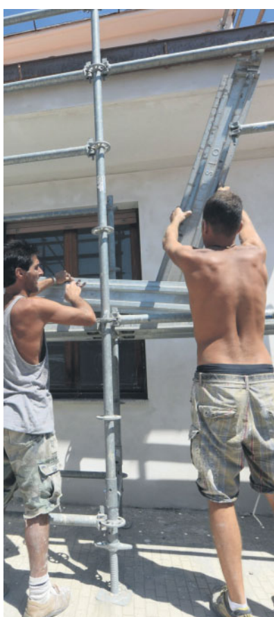
Operai al lavoro in un cantiere FOTO ANSA
