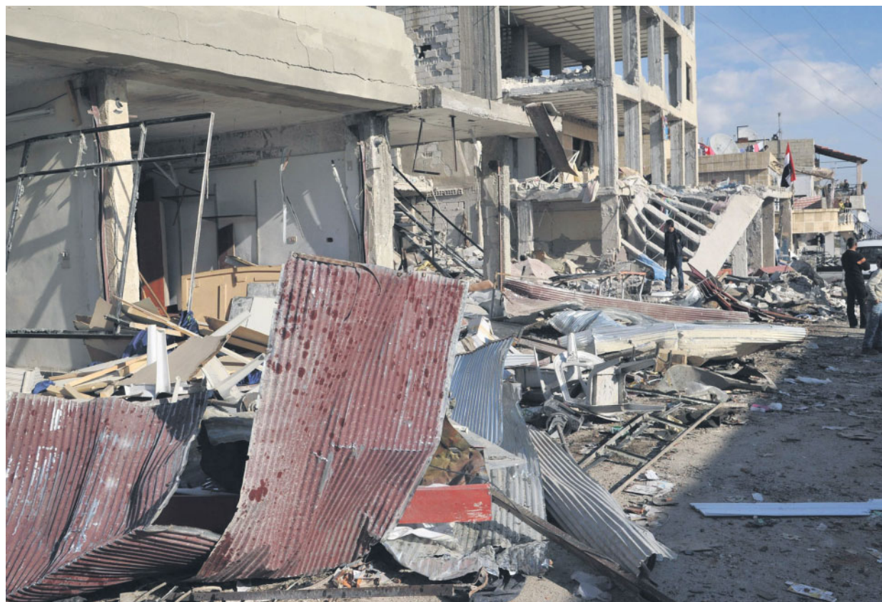
Macerie dopo l'esplosione di un'autobomba a Damasco FOTO ANSA
