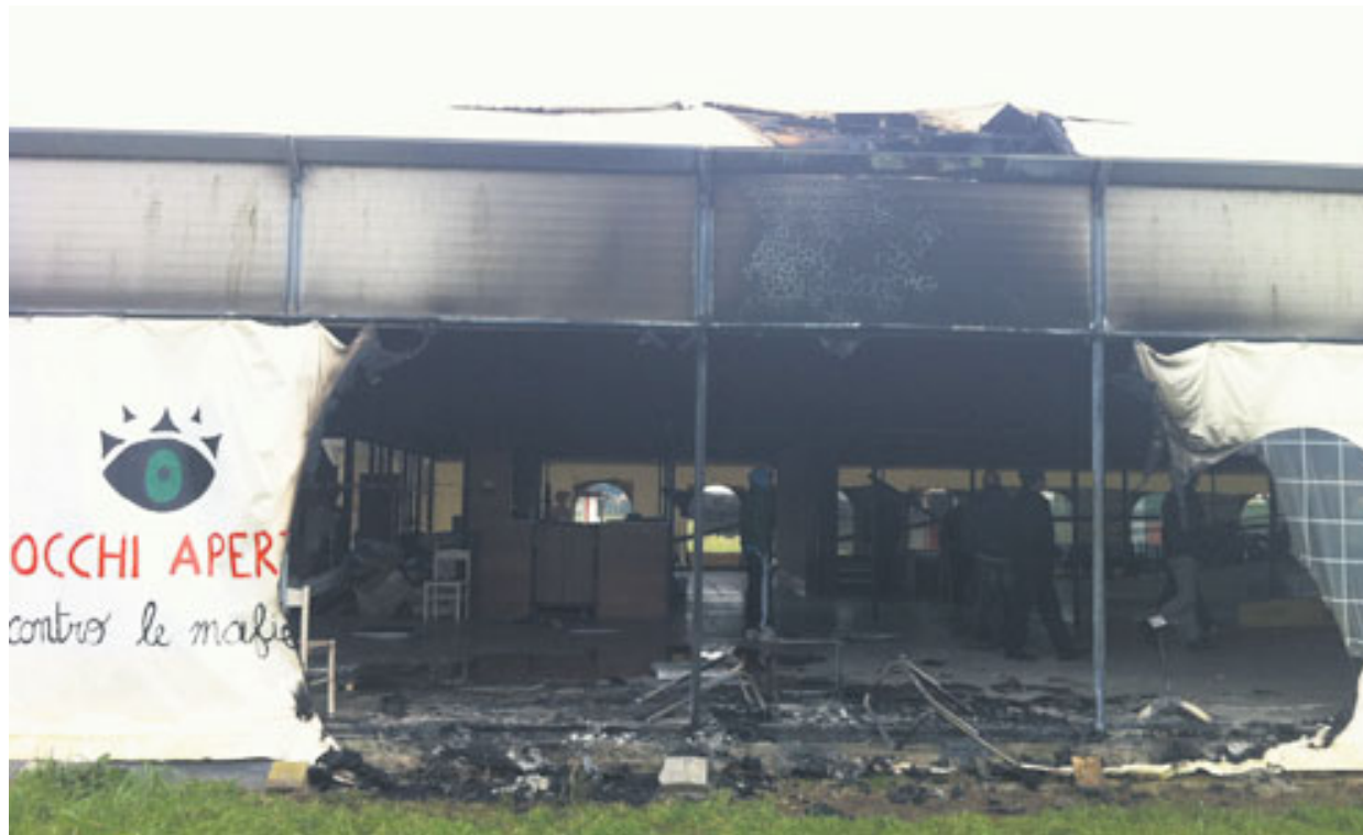
La tensostruttura andata a fuoco a Borgo Sabotino in provincia di Latina
