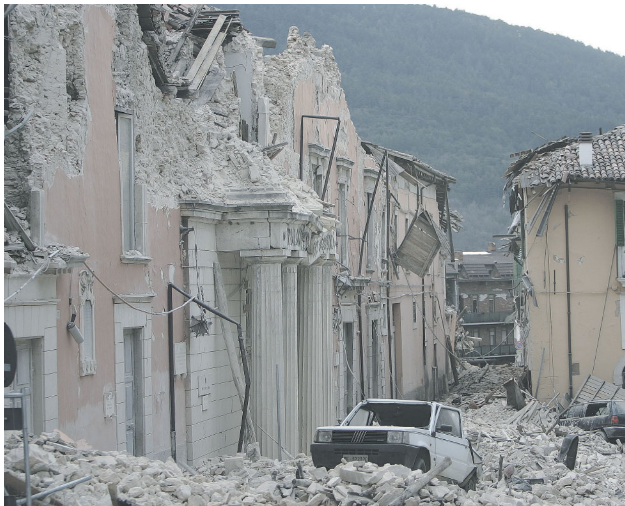
Il centro de L'Aquila distrutto dalle scosse del terremoto FOTO LAPRESSE
