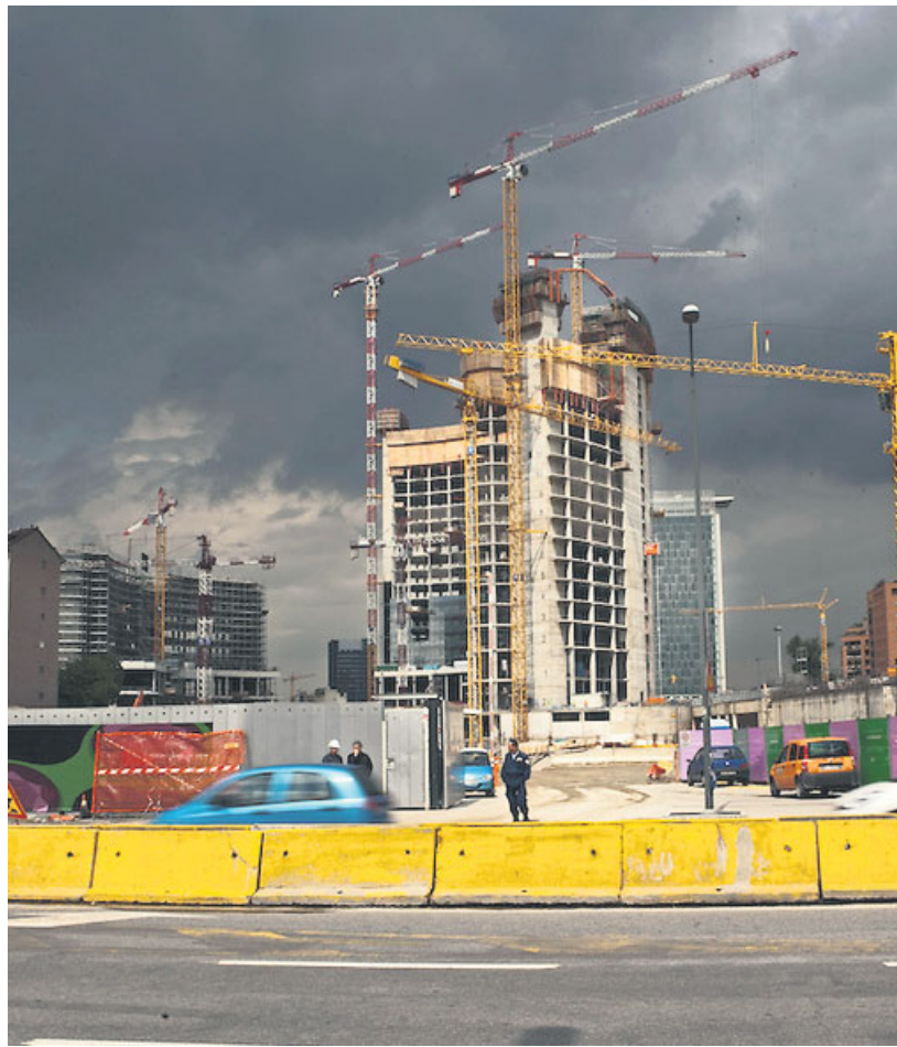
Lavori nel cantiere di Porta Nuova a Milano
