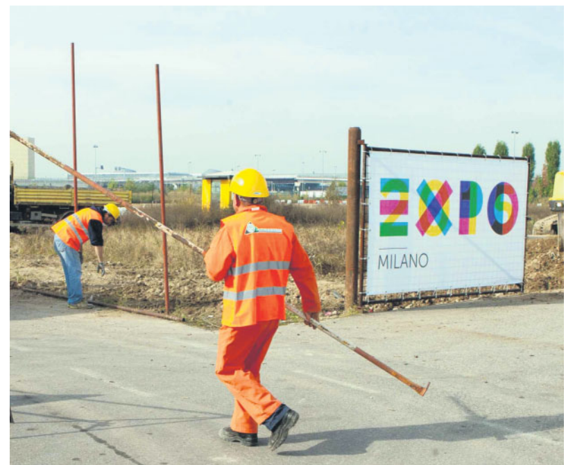
Un cantiere per l'Esposizione universale di Milano GREGO/FOTO INFOFOTO
