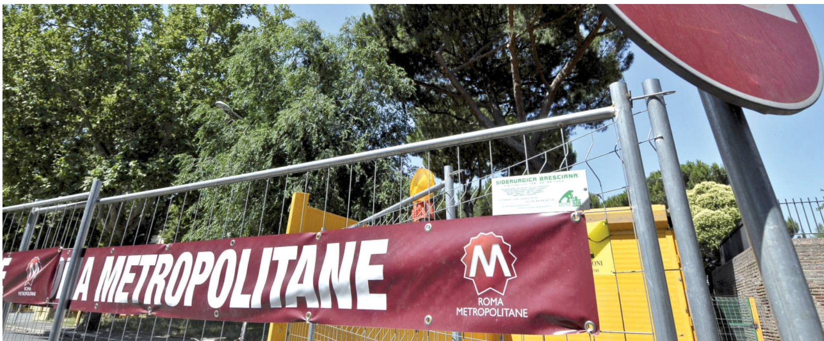
Lavori per la costruzione della Metro C di Roma FOTO LAPRESSE
