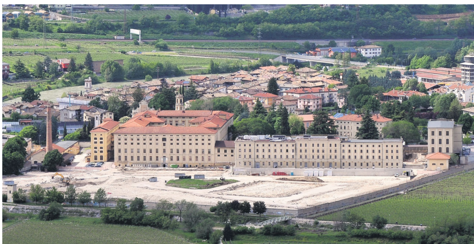
Una veduta dell'edificio austro-ungarico della Manifattura Tabacchi di Rovereto: davanti sorgeranno gli spazi pubblici da costruire entro il 2018
