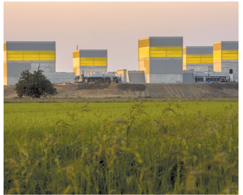
Il Green Data Center dell'Eni, inaugurato ieri nel Pavese
