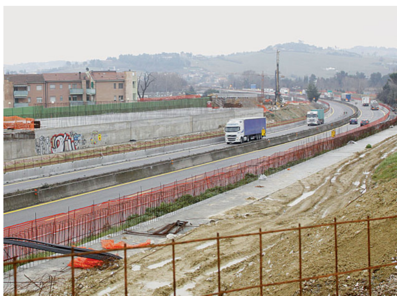
I lavori sull'A14 tra Fano e Cattolica
