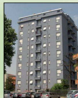
RISTRUTTURAZIONE EDIFICI SETTIMO MILANESE
