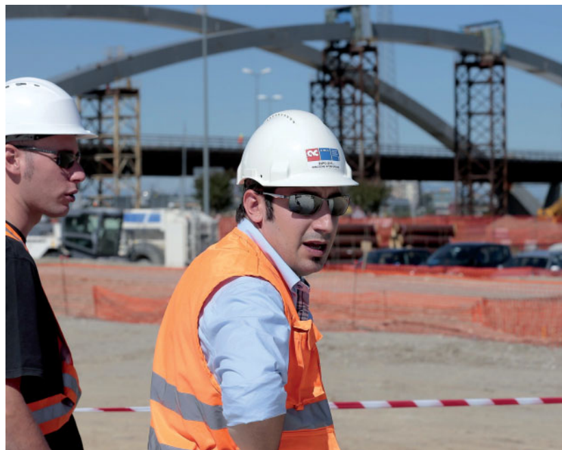
Il cantiere di Milano Expo 2015 FOTO LAPRESSE
