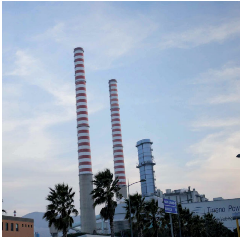
La centrale Tirreno Power di Vado Ligure. FOTO DI ANDREA NEGRO/L'ESPRESSO
