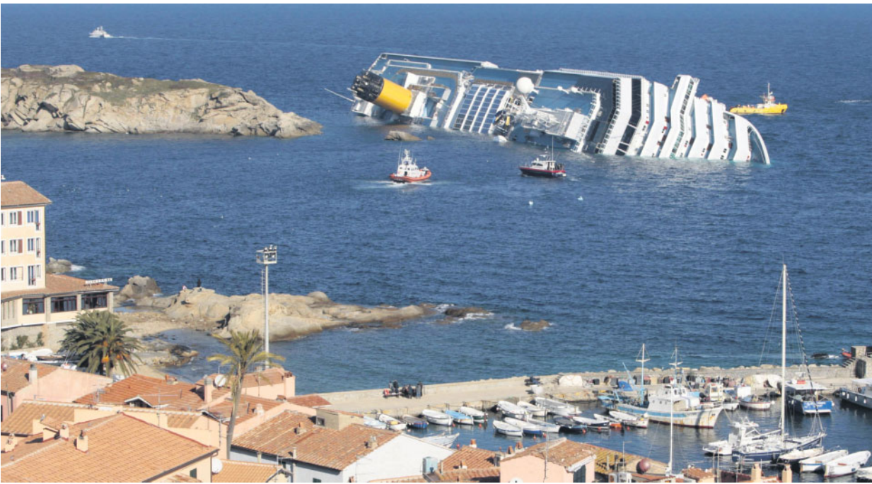
Lo spostamento del relitto della Costa Concordia dovrebbe essere effettuato entro settembre FOTO AP
