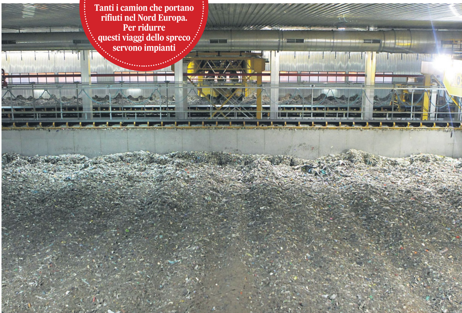
L'area Tmb, Trattamento Meccanico Biologico di Malagrotta FOTO LAPRESSE
